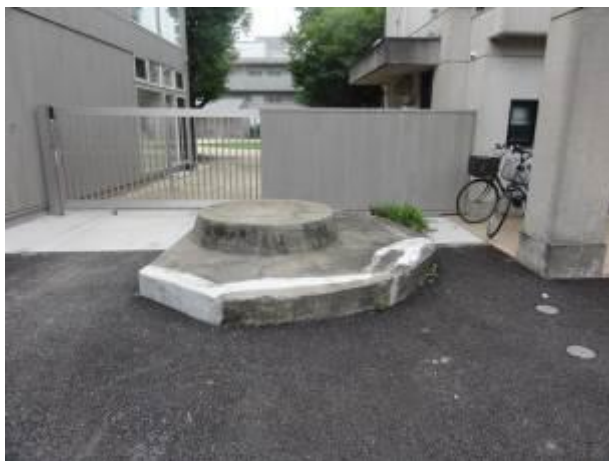
門扉の前にある高射砲台座跡 本来は円盤の形状だったが、通行のために コンクリートの一部が切り欠かれている
