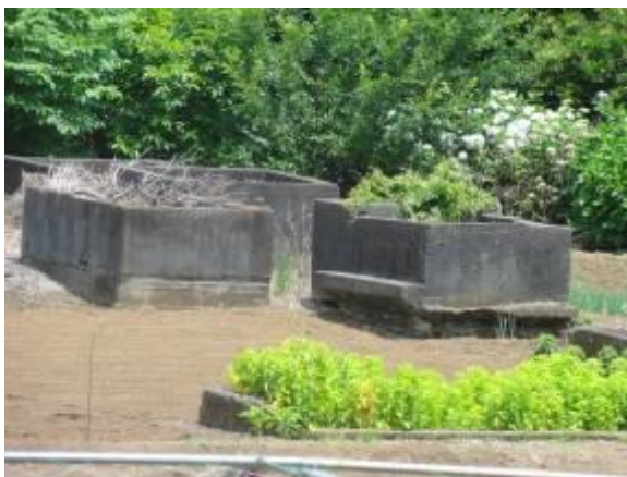
衣笠高角砲台の部隊がふもとに設営したという兵舎の遺構。 これは水をためていたものだろう。
