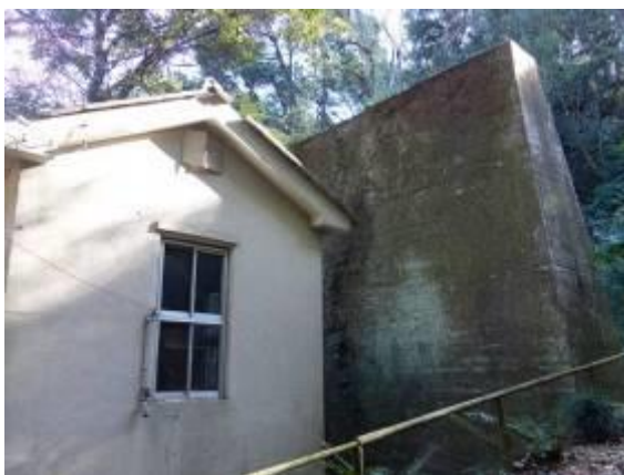
火薬庫と背後のコンクリート壁 強固なコンクリート壁で隣の広場 と隔てている
