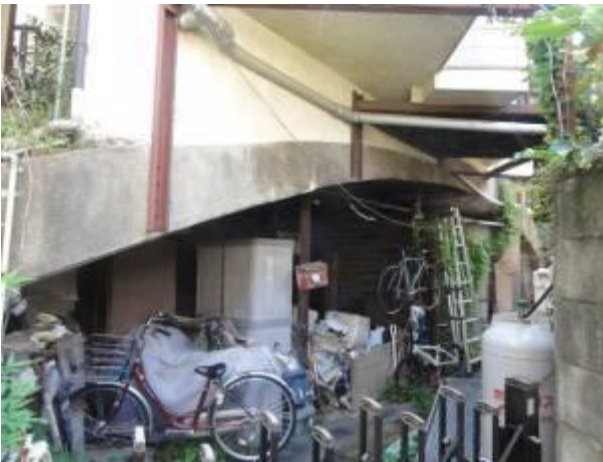
旧成増飛行場の掩体壕跡 円弧状のコンクリートの中が物置として 利用されている。
