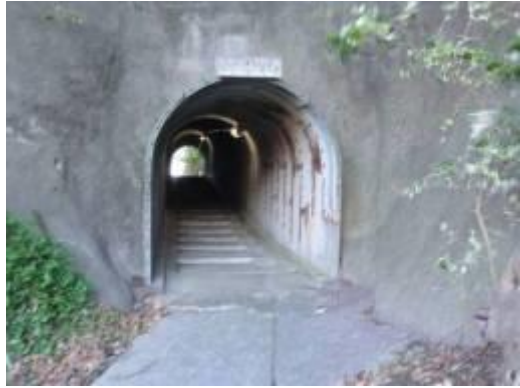
逗子・住吉神社近くの小さなトンネル 入口上の表示板に「住吉隧道」と書かれていた。
