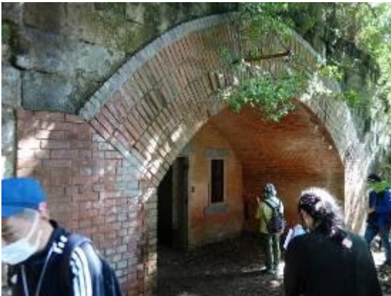
横須賀防備のための砲台施設跡 ここは砲兵が待機する場所だったらしい。 弾薬庫という説もある。
