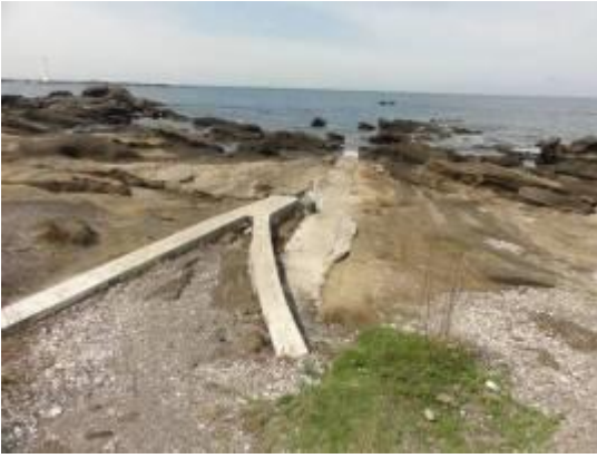
新井浜のコンクリート軌道 震洋を沖に出すためのガイドレール だったのだろう
