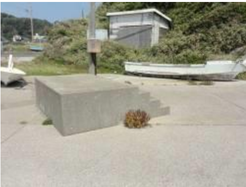
怪しいコンクリート台 毘沙門漁港の海岸で
