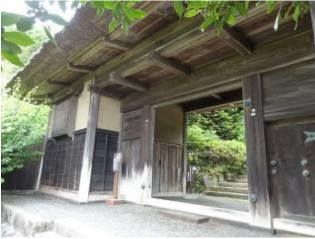
小田原市小船 かやぶき屋根の長屋門
