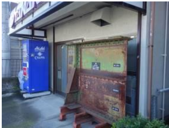
旧青橋の橋桁部分 (小田原寿町の道路沿いで) 機銃弾痕があることが示されている。 廃材のレールが台になっている。
