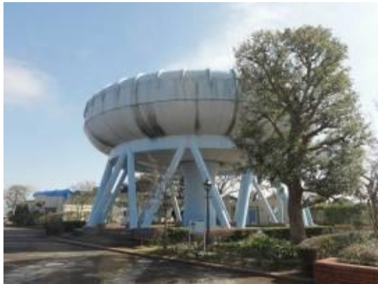
巨大な水道タンク 横浜水道記念館の敷地で
