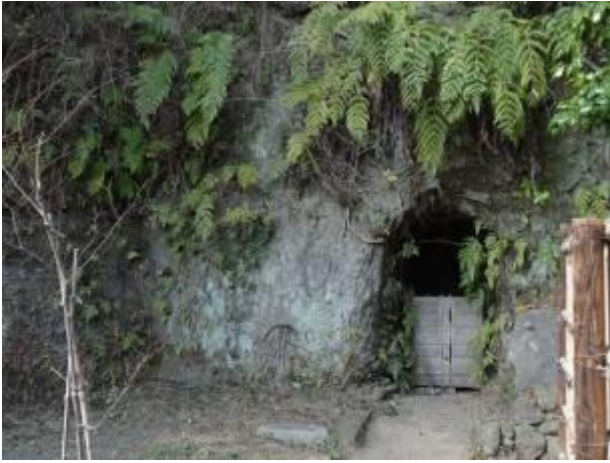
老樗荘の背面の壁にある防空壕 2013/2/22 撮影
