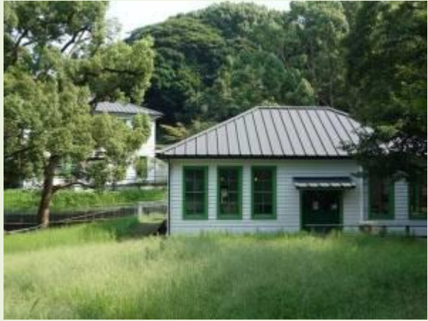
横浜検疫所・旧細菌検査室
