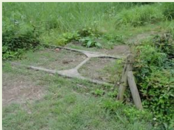
戦車のシャシーとの説もある鉄骨構造の仮橋
